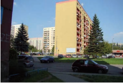
Il.14. Ściana szczytowa budynku.
