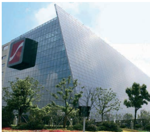
Il. 5 Centrum badawczo-rozwojowe Wuxi Suntech Power, Wuxi. Szklaną fasadę BiPV tworzy 2552 semitransparentnych paneli fotowoltaicznych o łącznej powierzchni 20 000 m 2 . fot. Suntech [5]
