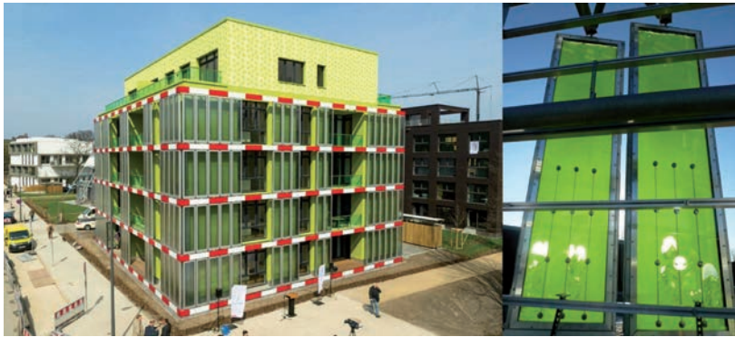
II. 8 Fasada algowa na budynku BIQ [15]
