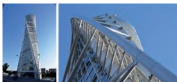
Fot. 18 Struktura budynku Turning Torso w Malmö w Szwecji projektu Santiago Calatrava, 1999-2005; fot. Anna Gumińska, 2016.
