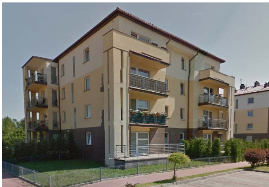
Il.1. Widok elewacji typowego budynku dla którego opracowano niniejszy artykuł.
