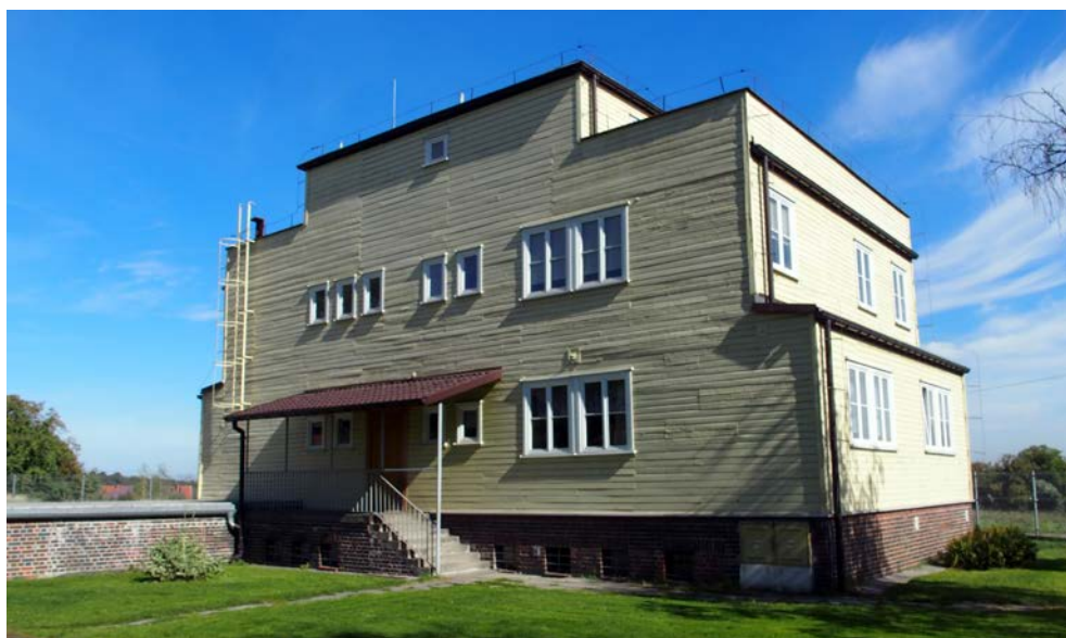
Il. 7 Budynek Obserwatorium – widok od południowego zachodu. Fot. A. Bednarski, 2016 r.
