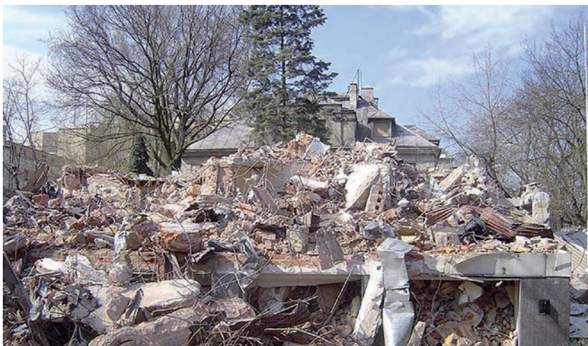
Il.1. Rozbiórka budynku – różnorodność materiału odpadowego fot. Mohamed Ahmad, 16.06.2016
