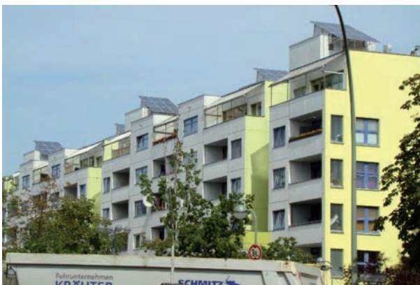
II.5. Widok paneli fotowoltaicznych zamontowanych na dachu budynków osiedla High-Deck w Berlinie.
