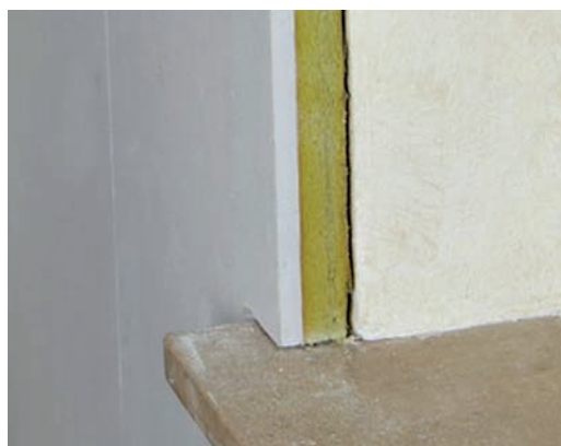
II.2. Aerowełna jako izolacja od wewnątrz (Materiały firmy Deutsche Rockwool Mineralwool. www.Aerowolle.de )
