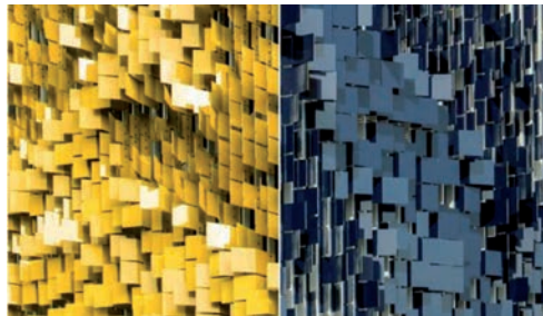
Il. 11 Zbliżenie na metalowe panele na elewacji parkingu szpitala Eskenazi w Indianapolis [17]
