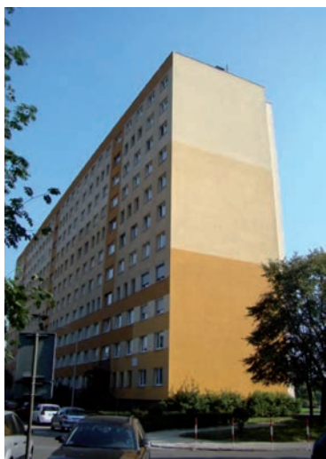
Il.11. Ściana szczytowa budynku.
